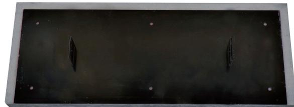
**3** 養生した上に踏み板を裏返して置き、受け鉄板の外周と穴位置をマーキングします。受け鉄板を外し、マークした穴位置に **φ 4.5 × 深さ 25 mm** の穴を開け、ダストポンプで切粉の清掃を行います。
