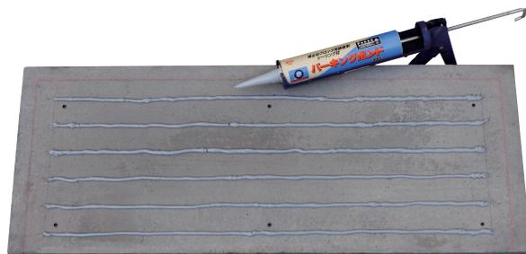
**4** GRC製 踏み板裏を清掃し、別売のボンドエフレックスを直径 5 mm の太さで写真のように 50 mm 間隔で 6 本塗布します。
