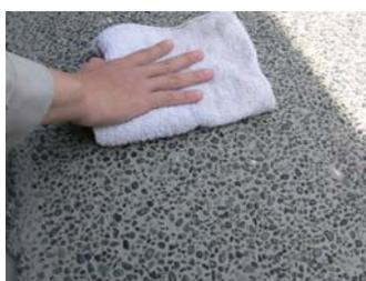
目地の硬化（爪で跡が付かなくなった状態）を確認してからキレイな布で表面をから拭き最終の仕上げを行います。
