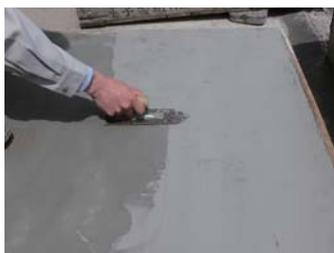
モルタル・コンクリート下地に適度な水湿しをしてから下塗材を約1mmの厚さでコテ塗りします。
