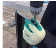
**8** 笠置本体(上部パーツ)の片側端部にエンドキャップを付属のタッピングビスで固定します。
