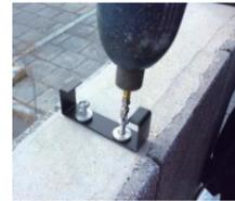
**4** 偏心プラグを打ち込み固定金具を固定します。打ち込みの際、固定金具が回る場合がありますので注意してください。固定金具をしっかりと押さえ、反対側のプラグを少しだけ打ち込んでから作業すると回りません。
