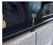
**7** 固定金具が配置されている箇所に笠置本体(下部パーツ)の上側から付属のタッピングビスを打ち込みます。
