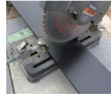
**5** 笠置本体(上部・下部パーツ)を必要な長さにカットします。※写真は笠置本体(上部・下部パーツ)を同時にカットしています。笠置本体の天端面を上にしてカットしてください。笠置本体(上部・下部パーツ)にバリが出た場合、やすり等で取り除いてください。
