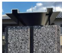
**6** 笠置本体(下部パーツ)を配置します。固定金具を笠置本体(下部パーツ)の溝に入れていきます。
