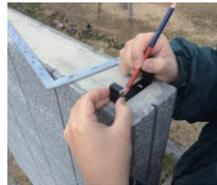
**1** 下穴をあける位置をマーキングします。固定金具の取付けは規定の間隔を守り、固定金具と固定金具を真直ぐに配置してください。
