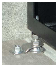
アジャストボルト押さえ金具とアンカー
