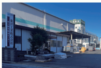
埼玉圏央物流センター 〒363-0002 埼玉県桶川市赤堀1-24
