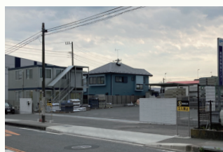
相模原物流センター 〒252-0243 神奈川県相模原市中央区上溝2-2-16
